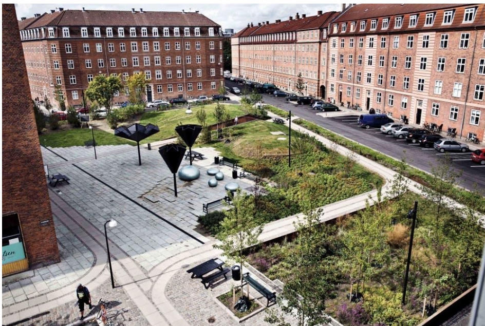
Figur 32 Tåsinge plats i Köpenhamn. Multifunktionell torgyta med plats för dagvatten- och skyfallshantering samt rekreationsområde. Bildkälla: (Public space, 2022)
